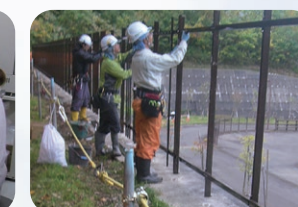
周囲柵修繕・改良
