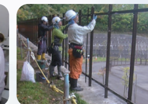
周囲柵修繕・改良
