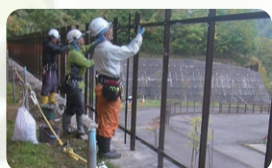
周囲柵修繕・改良
