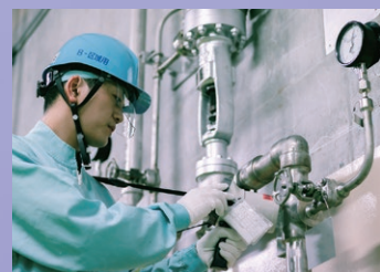
配管の放射線量測定
