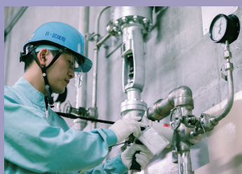
配管の放射線量測定
