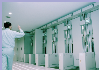
体表面ゲートモニタの点検
